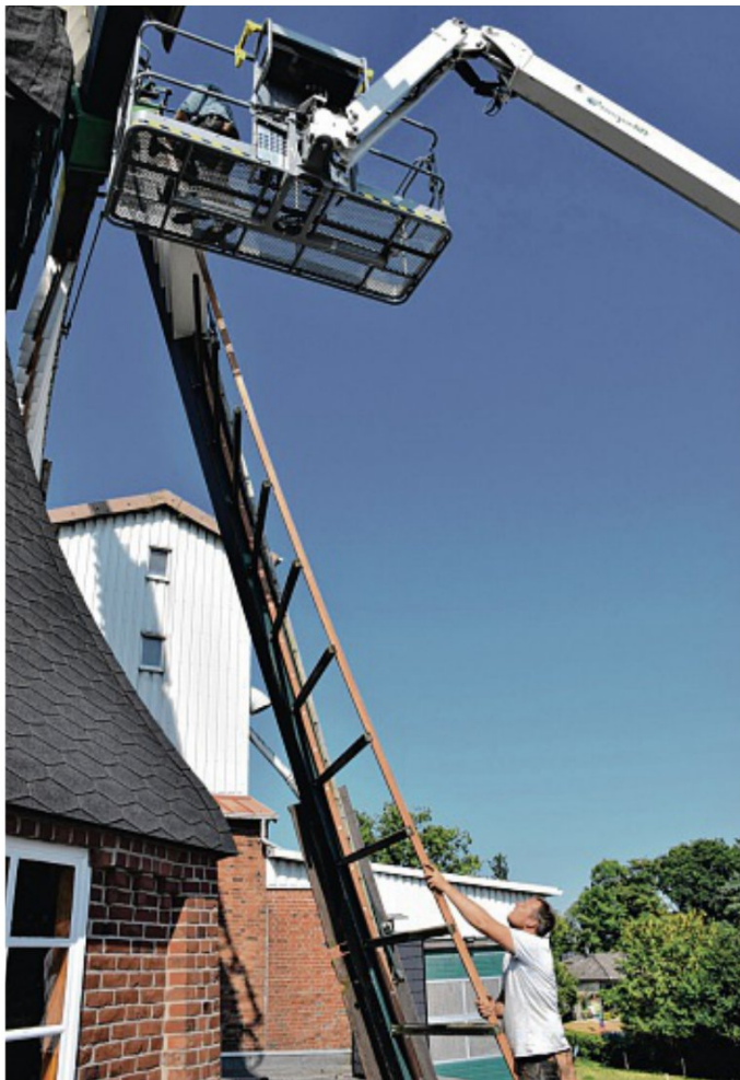
Ronny Beckmann beginnt oben mit der Befestigung der Saumleiste, die sein Sohn Dennis von unten in die richtige Position bringt.
