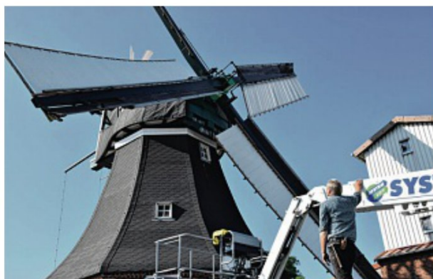
Nachdem alle acht Saumleisten ausgetauscht und alle 104 Jalousielamellen wieder abgebracht wurden, überprüft Ronny Beckmann, ob das Windrad wieder richtig dreht. Fotos: K. Bernhardt
