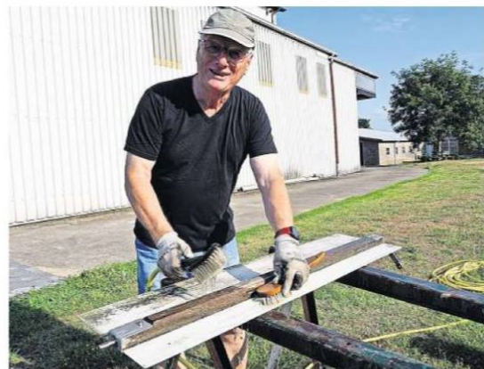
Klaus Radtke vom Mühlenverein nutzt die Arbeiten an den Flügeln, um die Lamellen der Mühle zu reinigen.
