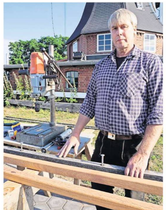
Zimmermann Ronny Beckmann zeigt die Saumleisten, die an den Flügeln der Mühle ausgetauscht werden. Vorn die neuen Leisten, hinten die alte.
