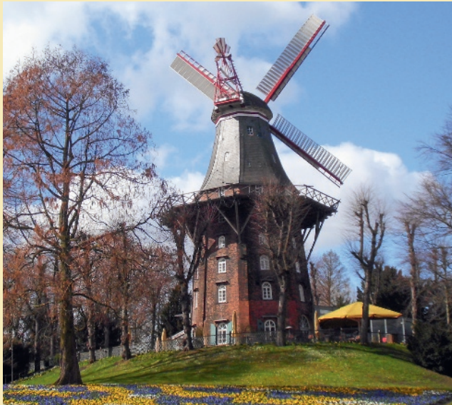
Die Mühle am Wall (Bremen) ist eine funktionsfähige, fünfstöckige Galerieholländerwindmühle aus dem Jahr 1833. Bereits seit 1898 ist sie im Besitz der Stadt und war noch bis 1947 als Getreidemühle in Betrieb. Mitte der 90er Jahre wurde sie ausgebaut und renoviert. Foto: Franz Schnelle
